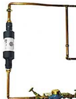
Installation dans le conduit après le compteur d'eau d'une maison
