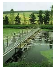
Station d'épuration avant
