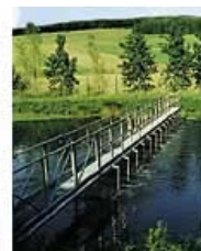
Station d'épuration après traitement
